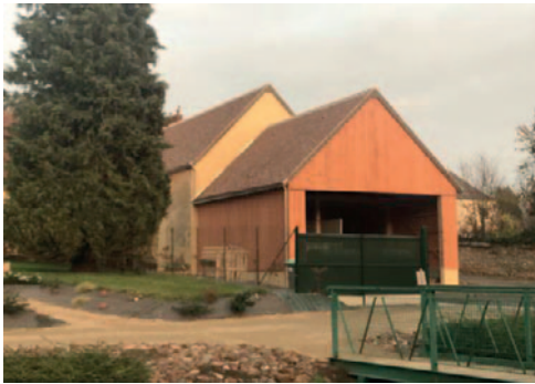
Le chantier terminé
